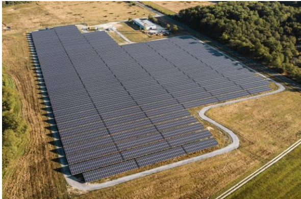
Centrale photovoltaïque Enoé de Saint-Julien-sur-Cher
