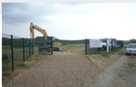
Clôture du site avec voirie interne
