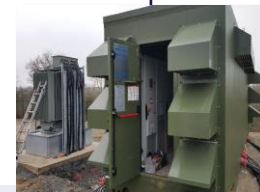
Mise en place postes de transformation et connexions avec les modules
