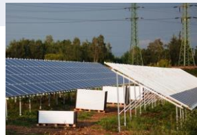
Installation des modules et vérification alignement
