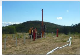
Pose des pieux battus
