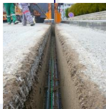
Pose des câbles dans les tranchées
