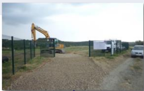
Clôture du site avec voirie interne
