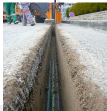
Pose des câbles dans les tranchées
