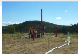
Pose des pieux battus
