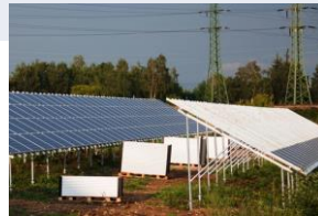
Installation des modules et vérification alignement
